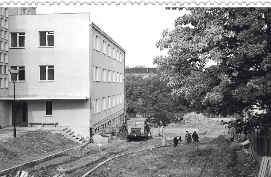
Budowa Szkoły - 1963 rok
