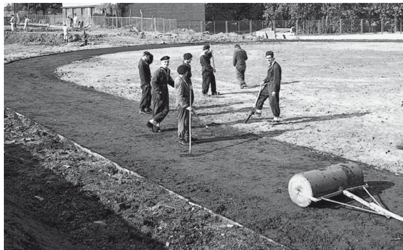
Budowa Szkoły - 1963 rok
