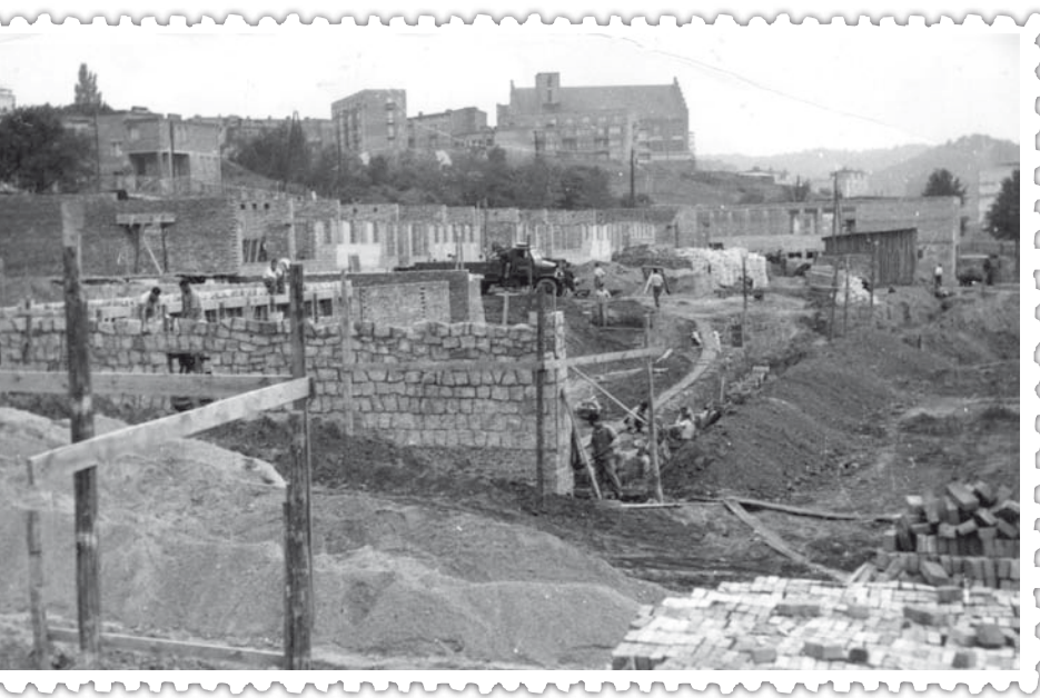
Budowa Szkoły - 1961 rok
