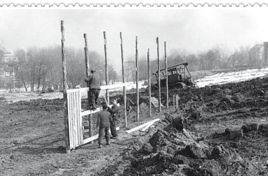
Budowa Szkoły - 1961 rok
