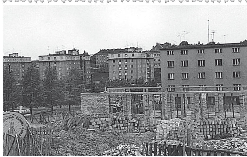
Budowa szkoły - 1961 rok
