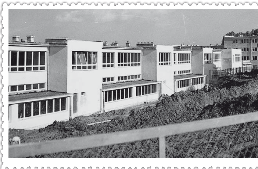
Budowa Szkoły - 1962 rok
