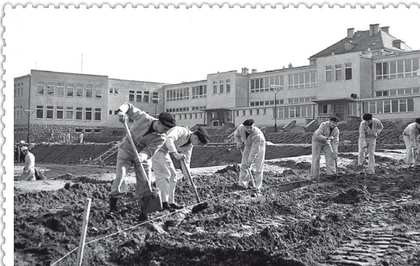
Budowa Szkoły - 1962 rok
