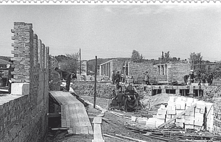
Budowa Szkoły - 1961 rok
