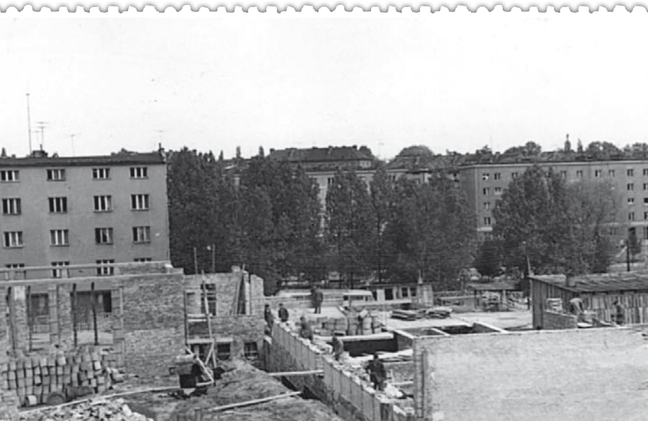
Budowa Szkoły - 1961 rok
