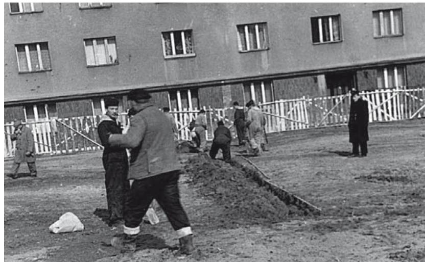
Budowa Szkoły - 1961 rok
