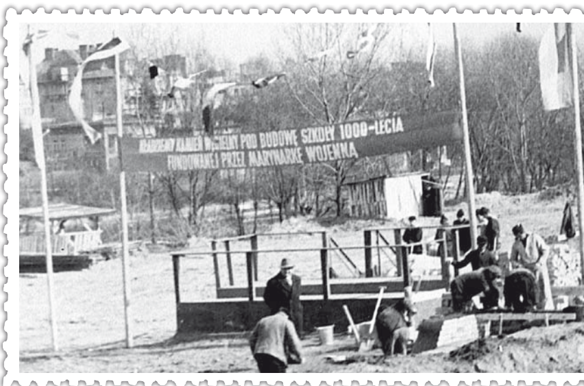
Położenie kamienia węgielnego pod budowę szkoły
