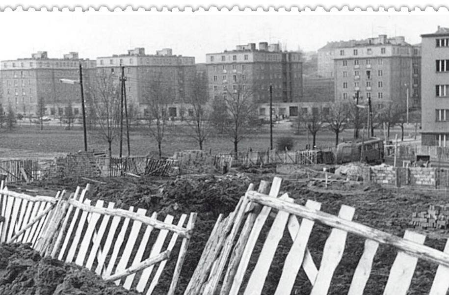
Budowa Szkoły - 1961 rok
