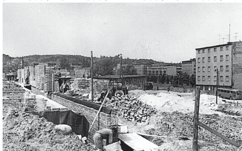
Budowa szkoły - 1961 rok
