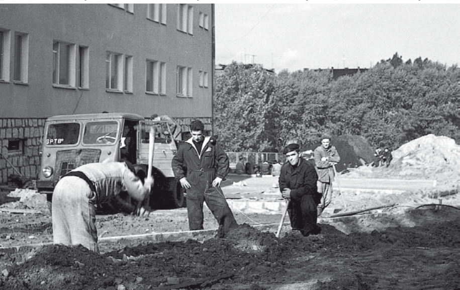
Budowa Szkoły - 1963 rok
