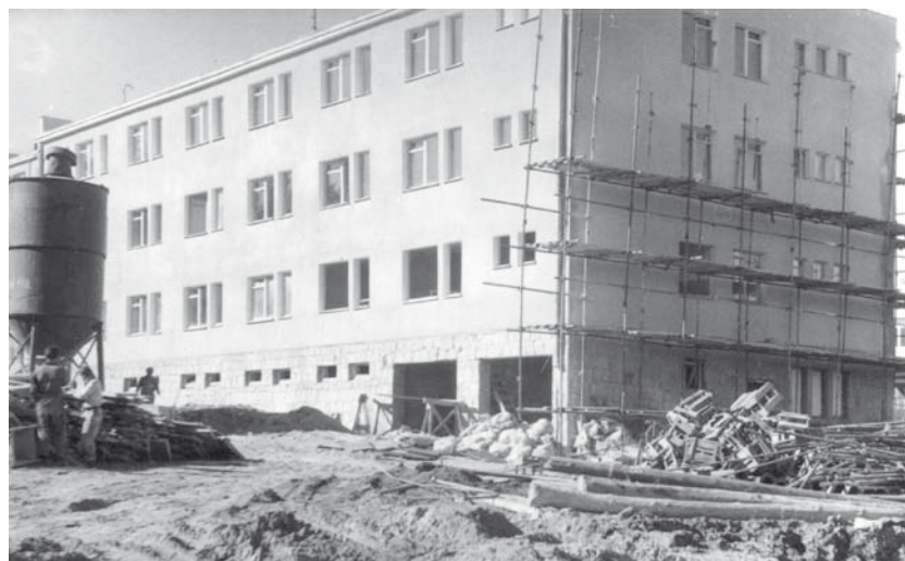
Budowa Szkoły - 1963 rok
