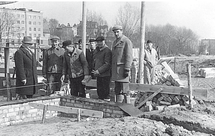
Budowa Szkoły - 1961 rok
