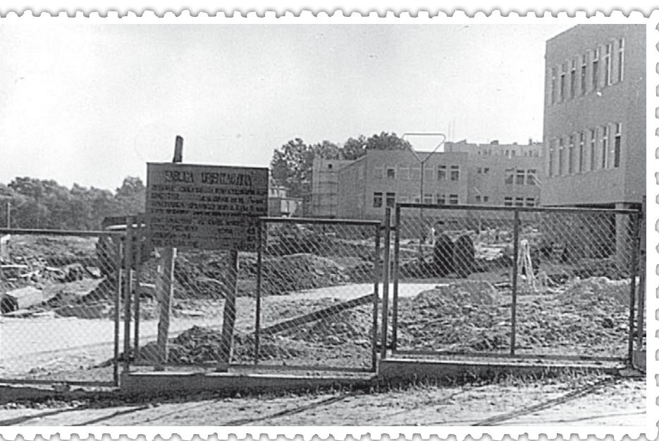
Budowa Szkoły - 1962 rok
